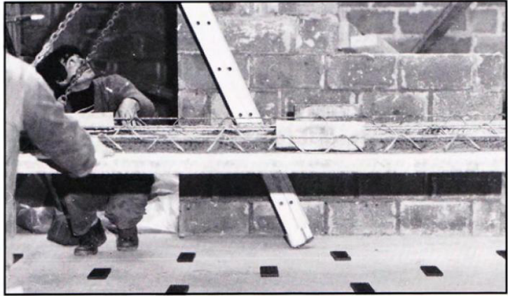
Verlegen eines schwimmenden Estrichs mit RUBLOC II.60.18.
